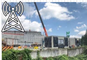
電源を引き込むのが 困難な工事現場
