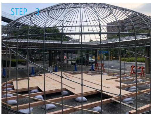
床工事（土嚢レベリング）
