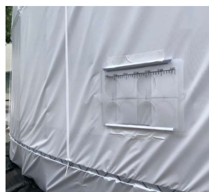
壁面空調給気・排気口
