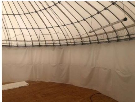
内幕材による内部金物養生
