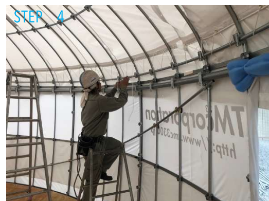
外装膜材張り
