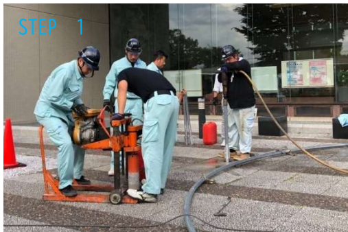
基礎杭工事（コア穴あけ・杭打ち込み）
